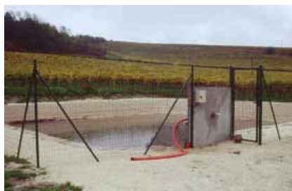
Bassin de stockage des effluents
