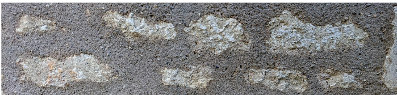
Mur de moellons en pierre vue
